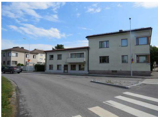
Tontin K III 10-32 rakennusten julkisivu itään.
