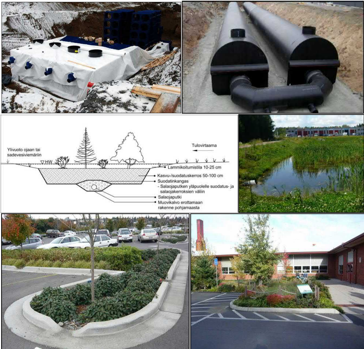
Kuva 7. Vasen yläkuva: Maanalaisen viivytystilavuudeltaan 300 m 3 kennoston rakentamista Tampereen Tykkitiekkadulla. Oikea yläkuva: esimerkki vedenpitävästä säiliöstä 6 . Vasen keskikuva: Tyypikuva biosuodatusrakenteesta 4 . Oikea keskikuva: esimerkki hulevesien hallinnasta Tuusulassa. Alakuvat: hulevesien hallinta pysäköintialueella ja koulun piha-alueella. 5
