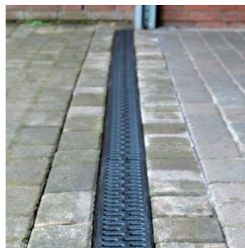
Till vänster: Linjär dräneringsränna Bild: www.aco-drain.fi
