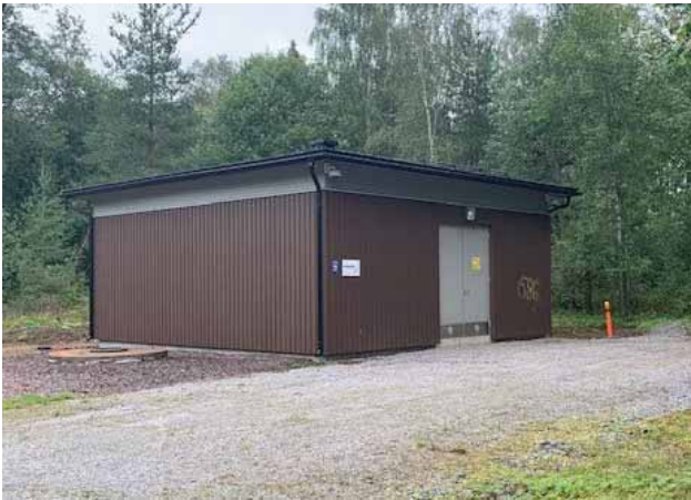
Bild 13. Fjärrvärmecentral Kuva 13 Kaukolämpökeskus.
