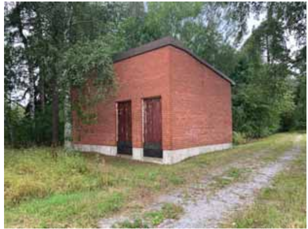
Bild 14. Transformatorstation Kuva 14. Muuntamo
