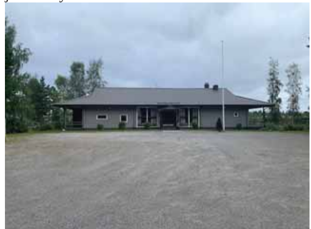
Bild 4. Sjönejdens hus, Korsgrundsvägen 32
