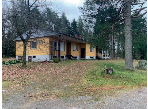
Bild 13. Bostadshus på fastighet 15:414 Kuva 13. Kiinteistön 15:414 asuinrakennus
