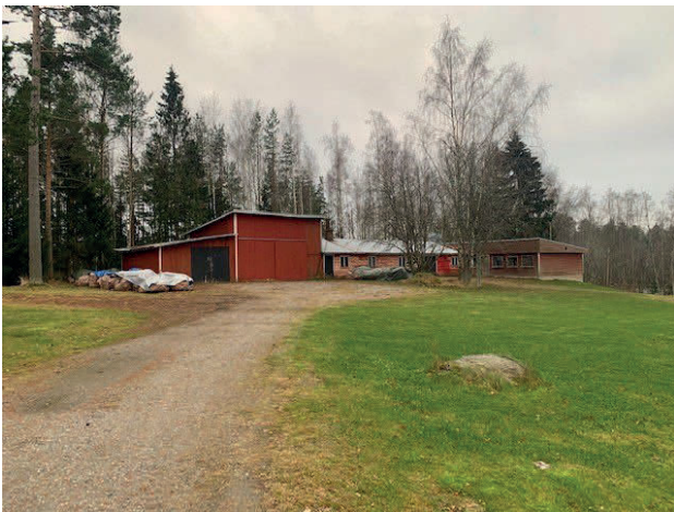
Bild 14. Uthus på fastighet 15:414 Kuva 14. Kiinteistön 15:414 ulkorakennuksia
