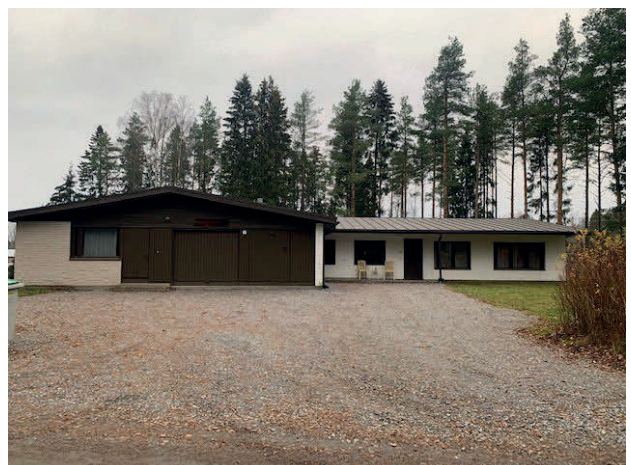
Bild 17. Bostadshus på fastighet 15:391 (Utanför detaljplaneområdet) Kuva 17. Kiinteistön 15:391 Asuinrakennus (Ase- makaava-alueen ulkopuolella)
