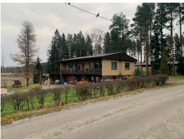
Bild 16. Bostadshus på fastighet 15:393 (Utanför detaljplaneområdet) Kuva 16. Kiinteistön 15:393 Asuinrakennus (Ase- makaava-alueen ulkopuolella)
