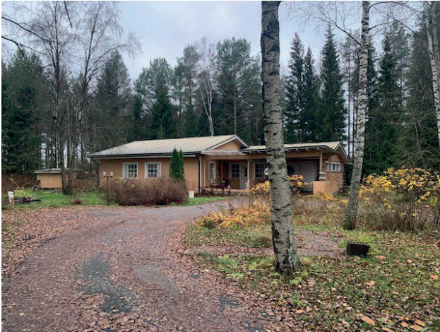
Bild 12. Bostadshus på fastighet 15:412 Kuva 12. Kiinteistön 15:412 asuinrakennus
