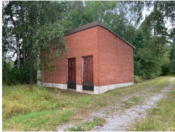
Bild 15. Transformatorstation Kuva 15. Muuntamo
