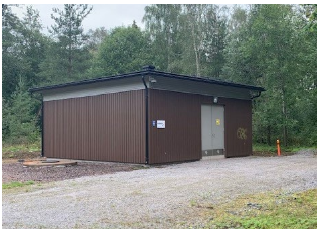
Bild 14. Fjärrvärmecentral Kuva 14 Kaukolämpökeskus.
