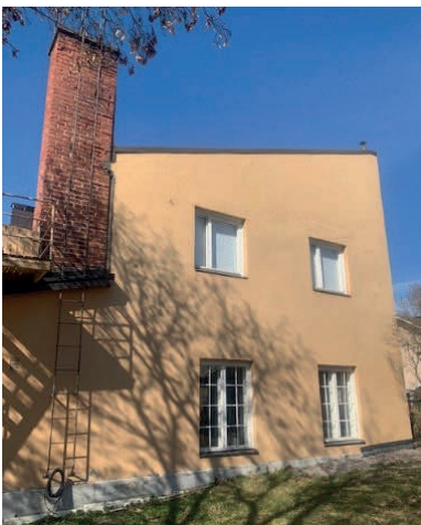
Bild 6. Huvudbyggnad, fasad mot söder Kuva 6. Päärakennus, julkisivu etelään
