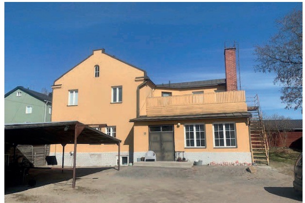
Bild 5. Huvudbyggnad, fasad mot Alholmsgatan/innergården Kuva 5. Päärakennus, julkisivu Alholminkadun/sisäpihan suuntaan
