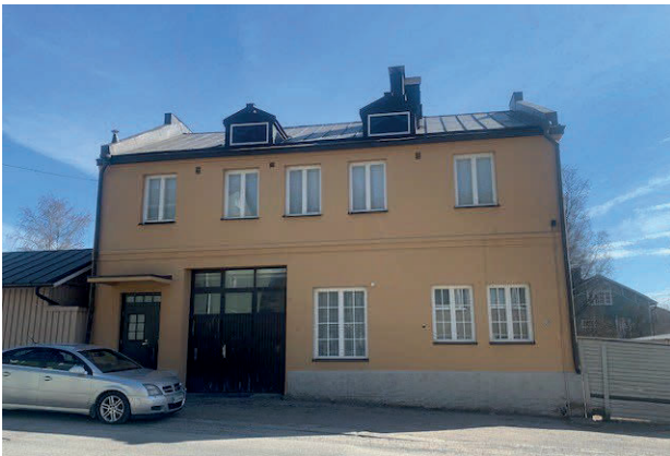
Bild 4. Huvudbyggnad, fasad mot Kvastbergsgatan Kuva 4. Päärakennus, julkisivu Luutavuorenkadun suuntaan
