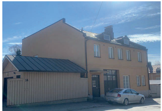
Bild 7. Huvudbyggnad, fasad mot Kvastbergsgatan Kuva 7. Päärakennus, julkisivu Luutavuorenkadulle
