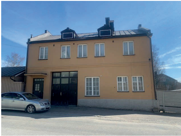
Bild 3. Huvudbyggnad. Fasad mot Kvastbergsgatan Kuva 3. Päärakennus. Julkisivu Luutavuorenkadun suuntaan
