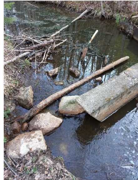
Figur 13. Gammal regleringsdamm nedströms Permofladan. Vattnet har eroderat en fåra runt dammens västra sida där fisk torde kunna passera vid tillräckligt vattenflöde. Foto: Anna Sundelin, bilden till vänster 3.10.2023, bilden till höger 16.5.2023.
