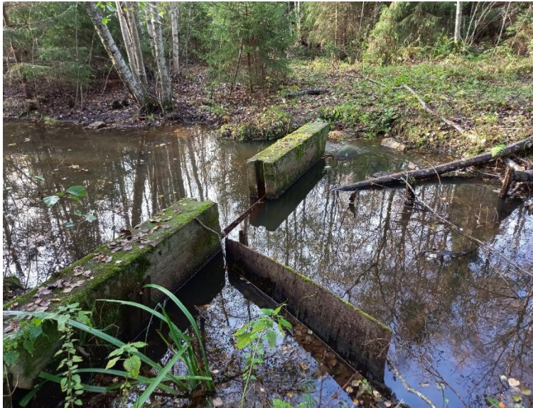
Figur 13. Gammal regleringsdamm nedströms Permofladan. Vattnet har eroderat en fåra runt dammens västra sida där fisk torde kunna passera vid tillräckligt vattenflöde. Foto: Anna Sundelin, bilden till vänster 3.10.2023, bilden till höger 16.5.2023.
