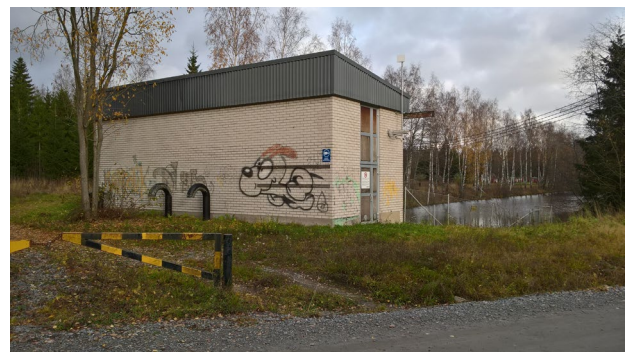
Bild 3. Pumpstationen och kanalen. Kuva 3. Pumppuasema ja kanava.
