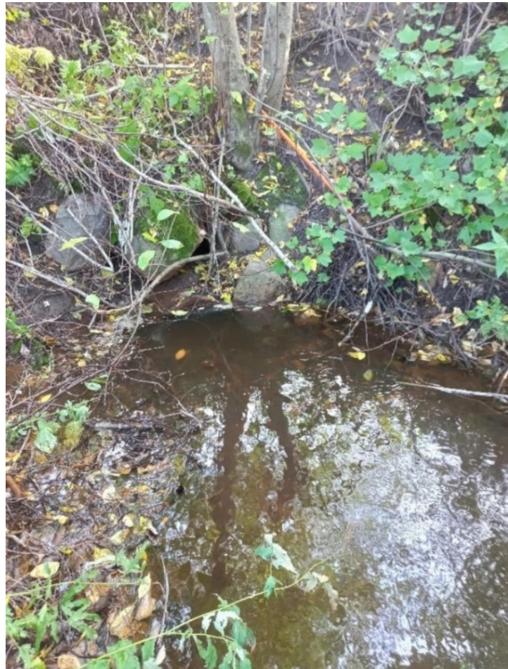
Figur 11. Vägtrumma, i vattendraget mellan Lövblomsfladan och Jakobstads ringväg, som korsar Gäddviksvägen. Vattenytan i nivå med vägtrummans övre kant. Foto: Anna Sundelin, 3.10.2023.
