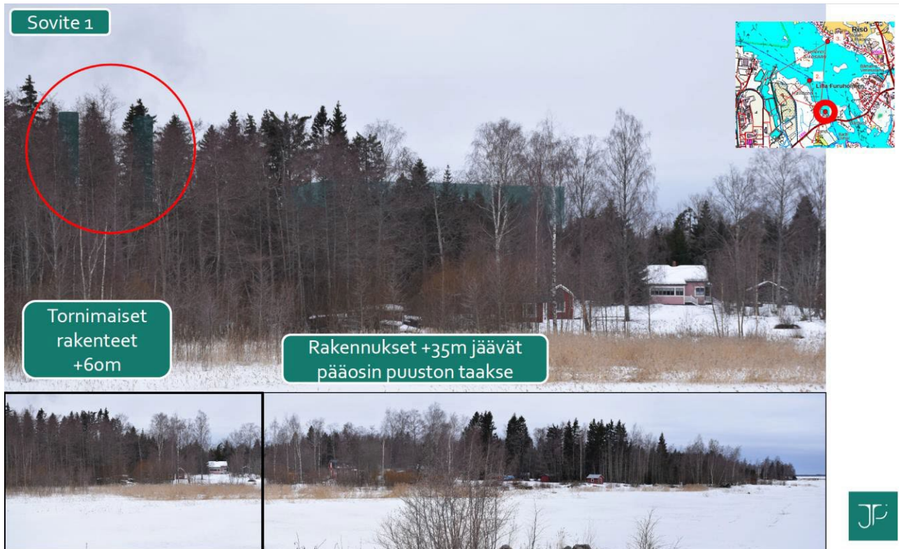
Bild 48. Fotomontage 1. Den södra kanten av Hällören, vid en befintlig brygga.
