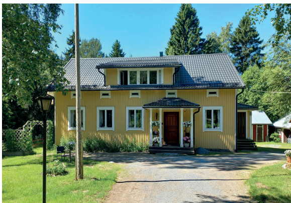
Bild 5. Huvudbyggnad, Vasavägen 66. Kuva 5. Päärakennus – Vaasantie 66
