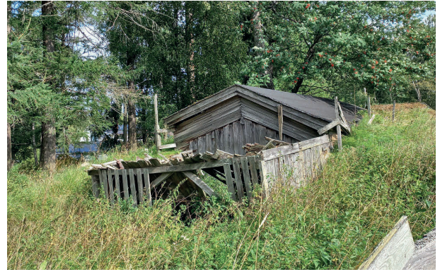
Bild 14. Källargrunden på vilken man byggt en takkonstruktion för fåren.
