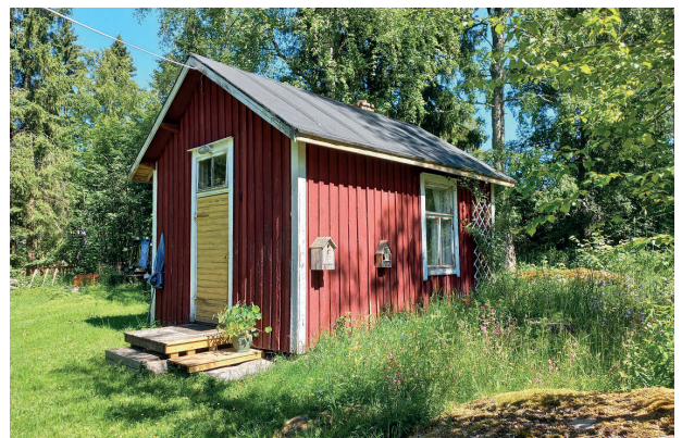
Bild 6. Gårdsbyggnad, Vasavägen 66. Kuva 6. Piharakennus Vaasantie 66
