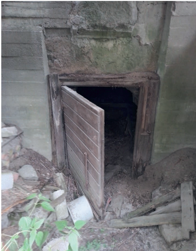
Bild 15 Gråstenskällarens förrum. Väggen mot källarrummet förstärkt med cement.
