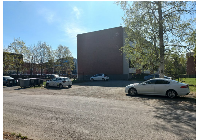
Bild 12. Tiainengatan 2b. Nordlig fasad och parkeringsområde mot Tiainengatan och det planerade svängområdet.
