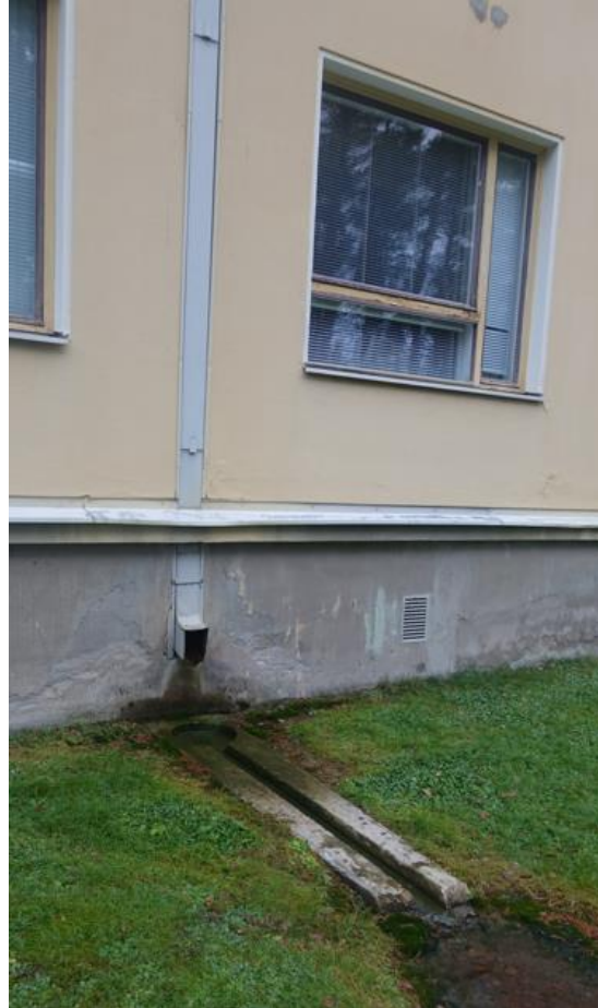
Syöksytorvet on integroitu tyylikkäästi rakennuksen julkisivuun (kuva läntiseltä julkisivulta).
