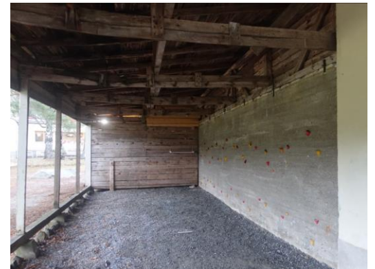
Lautarakenteisen avovaraston kattotuolit ovat hienot. Betoniseinällä voi kiipeillä.
