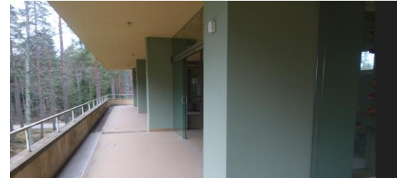
Näkymä länsisiiven parvekkeelta. Osa tiloista on myöhemmin lasitettu.
