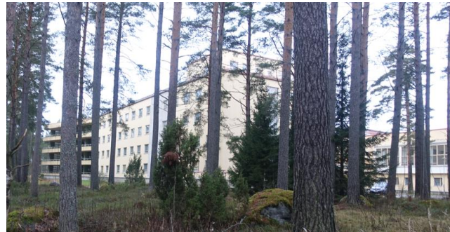
Rakennus kuvattuna kaakosta, kuvassa näkyy rakennusosat C ja B.
