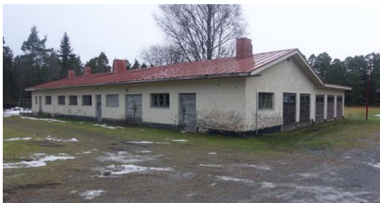
Näkymä rakennuksen pääsisäänkäynniltä. Eteläinen julkisivu.
