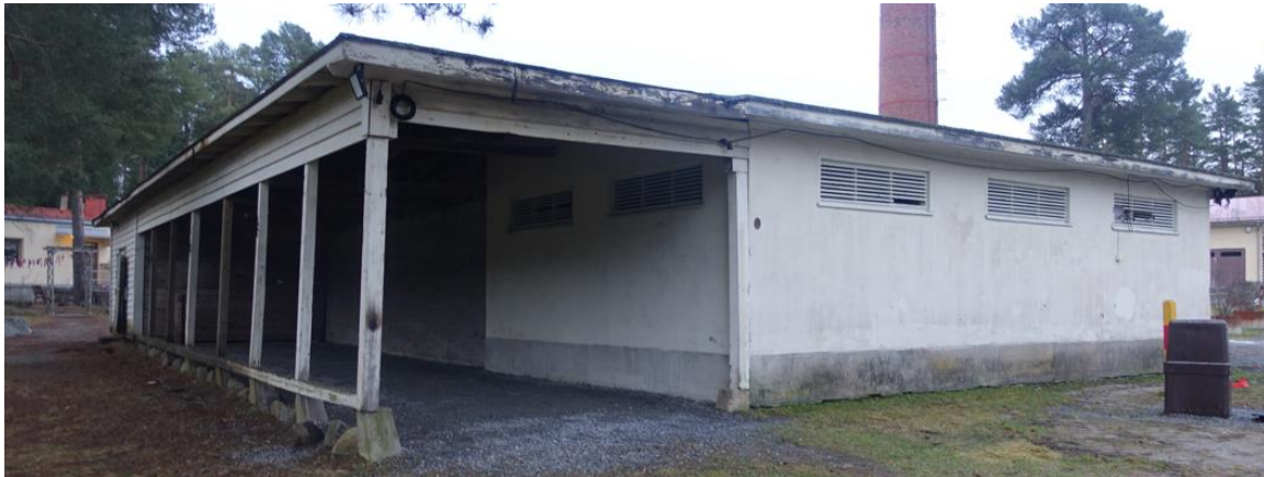
Julkisivut pohjoinen-länsi. Laajennusosa on lautarakenteinen.
