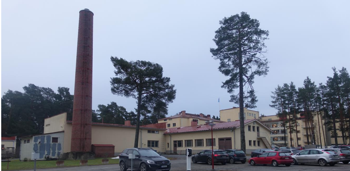
Rakennus kuvattuna parkkipaikalta. Julkisivut itä-pohjoinen.
