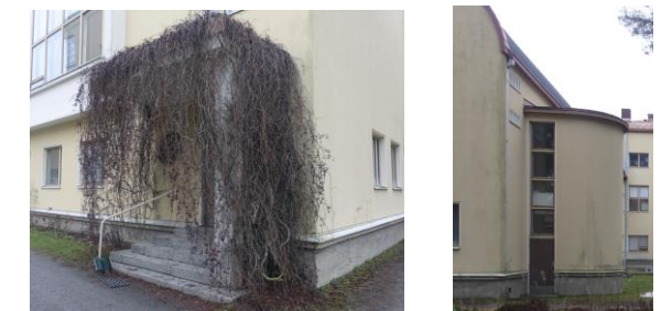
Henkilökunnan sisäänkäynti rakennusosaan B vasemmalla. Porrashuone oikealla.
