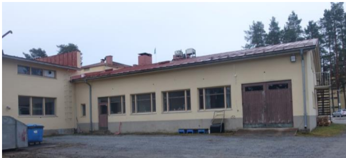
Lähikuva itäisestä julkisivusta.
