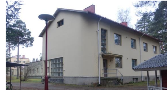
Laajennusosa vuodelta 1954. Julkisivut itä-pohjoinen.
