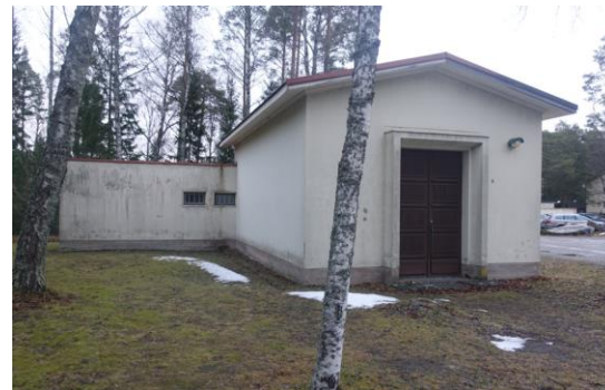
Näkymä rakennuksen pääsisäänkäynniltä. Eteläinen julkisivu.
