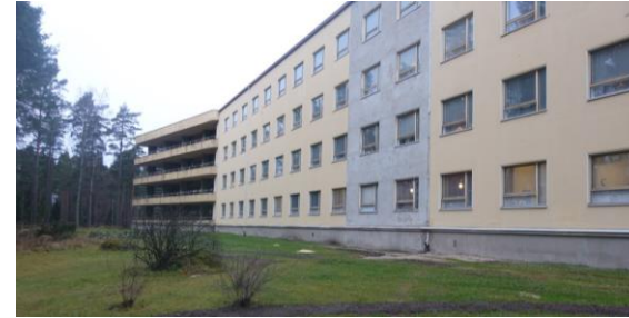
Näkymä eteläiseltä julkisivulta. Harmaana näkyy kesällä 2024 tehty koerappaus.
