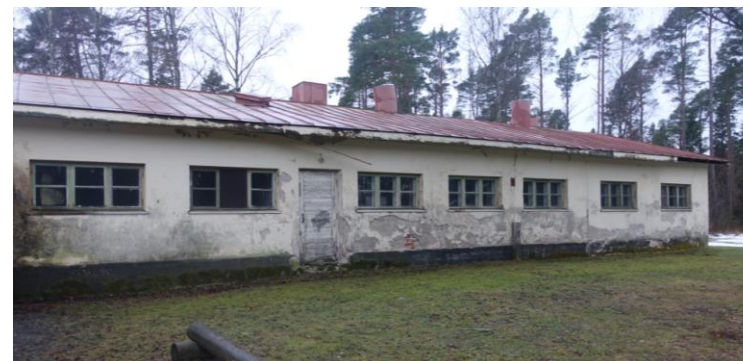
Lähikuvia pohjoisesta julkisivusta.
