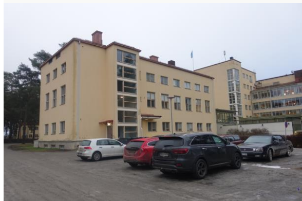
Rakennusosa A, pohjoinen ja läntinen julkisivu.
