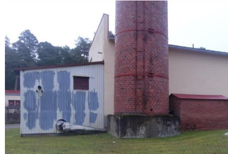
Lähikuva piipun juuresta ja lisärakenteesta pohjoisella julkisivulla.
