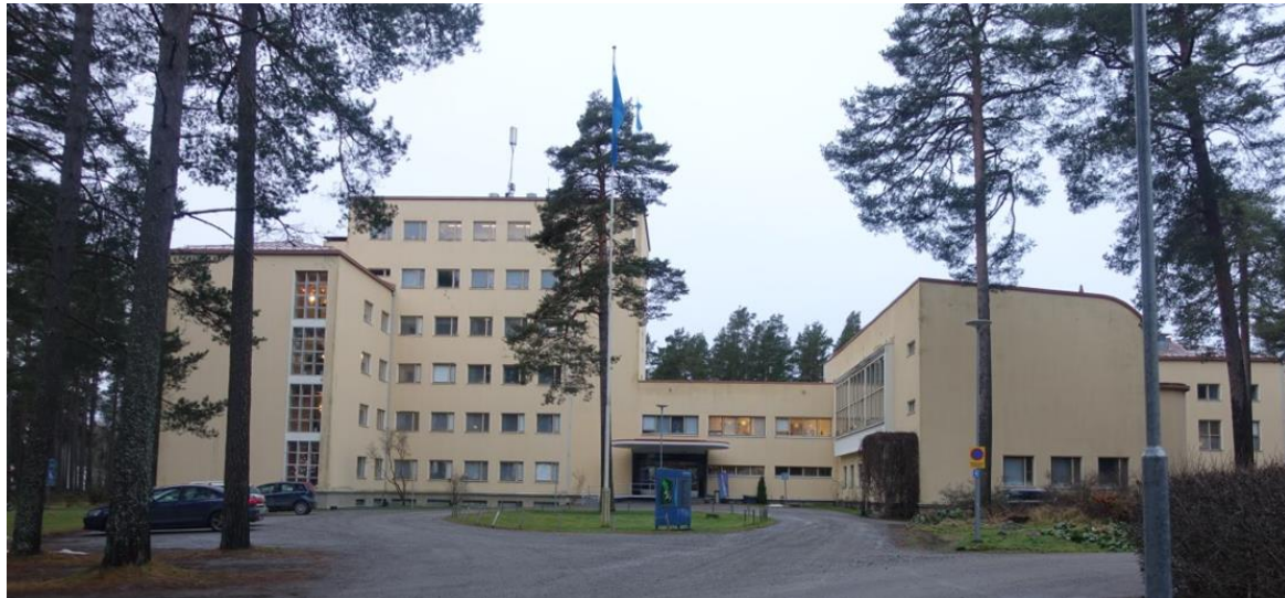
Itäinen julkisivu, pääsisäänkäynti (rakennusosat C, B ja A) .
