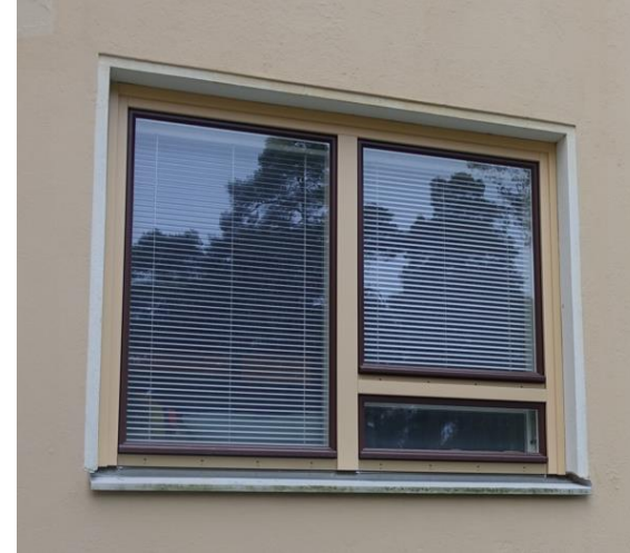
Vaihdettu ikkuna vuodelta 2024.
