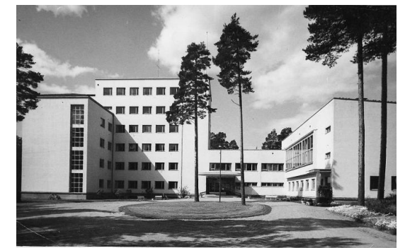
Itäinen julkisivu. Rakennusosaa C on kuvassa korotettu jo yhdellä kerroksella. Valokuva 1960-luvulta. 7
