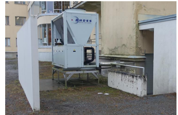
Myöhemmin lisättyä tekniikkaa on pyritty naamioimaan seinäkkeillä (eteläinen julkisivu).
