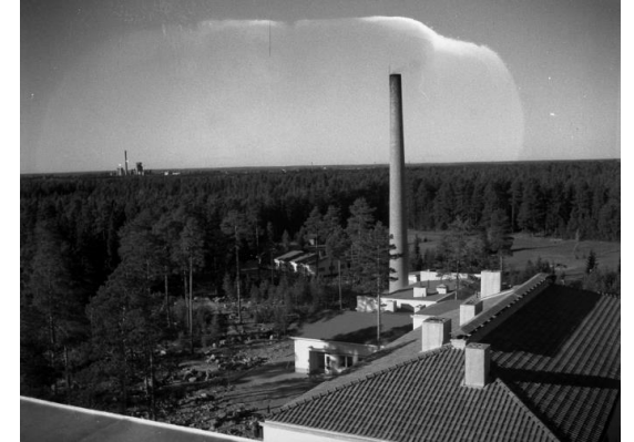
Näkymä rakennusosan C katolta. Rakennusosassa A tiilikate.
