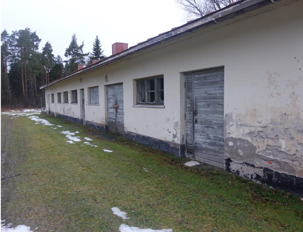
Lähikuva eteläisestä julkisivusta.
