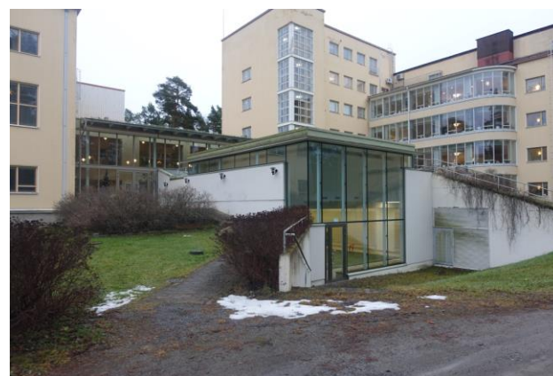
Rakennusosa D (allasosasto).
