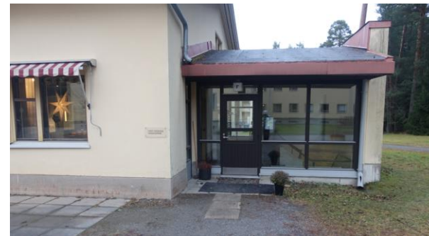
Vuoden 1983 käyttötarkoituksen muutoksen yhteydessä tehty uusi sisäänkäynti.
