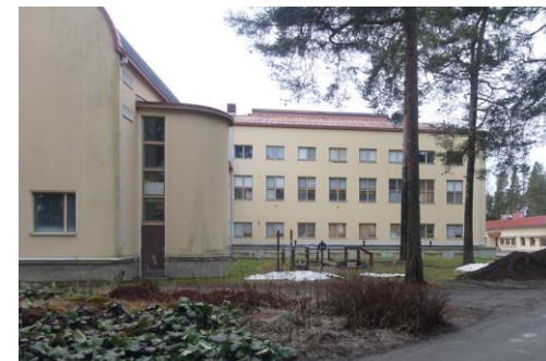
Rakennusosat B ja A.
