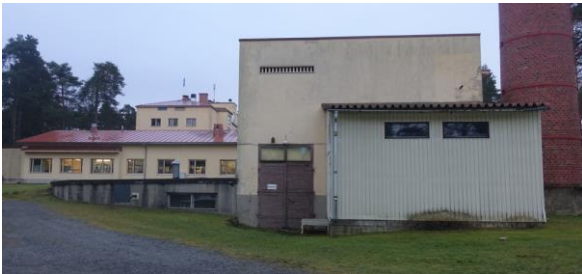
Eteläinen julkisivu. Edessä kokonaisuuteen sopimaton rakenne.
