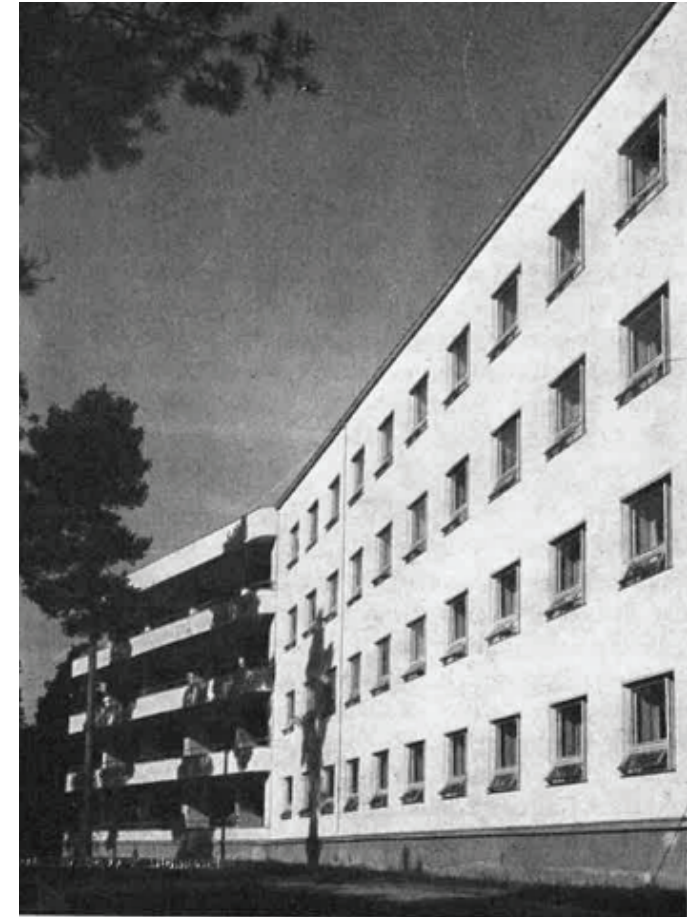
Östanlidin parantolan läntien julkisivu n. 40-luvulta. 24
