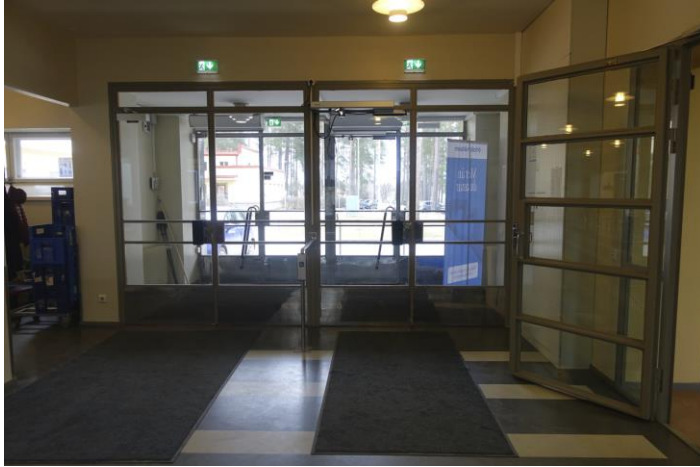
Tuulikaappi aulatilasta kuvattuna.
