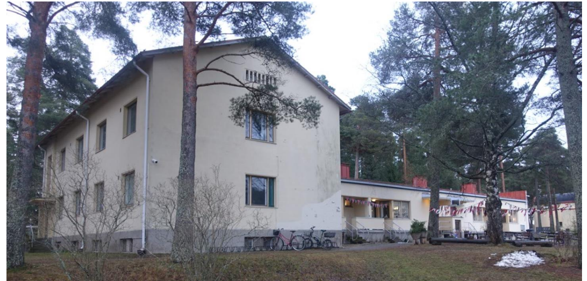
Julkisivut pohjoinen-länsi. Etusijalla laajennusosa.
