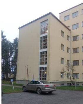
Portaikon näyttävät ikkunat.
