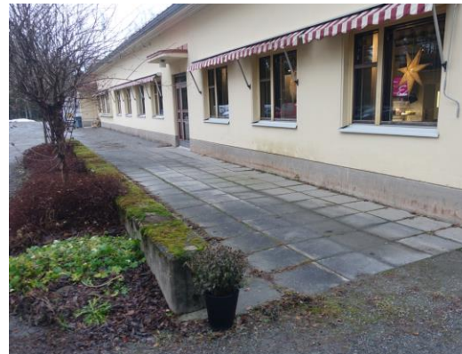
Lähikuva eteläisestä julkisivusta.
