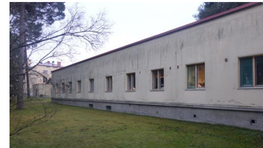
Itäinen julkisivu (alkuperäinen rakennusosa).
