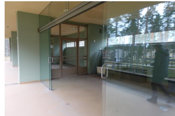
Osa länsisiiven parven yksiköistä on lasitettu myöhemmin. Lasitus on toteutettu julkisivua heikentämättä syvemmälle rakenteeseen.
