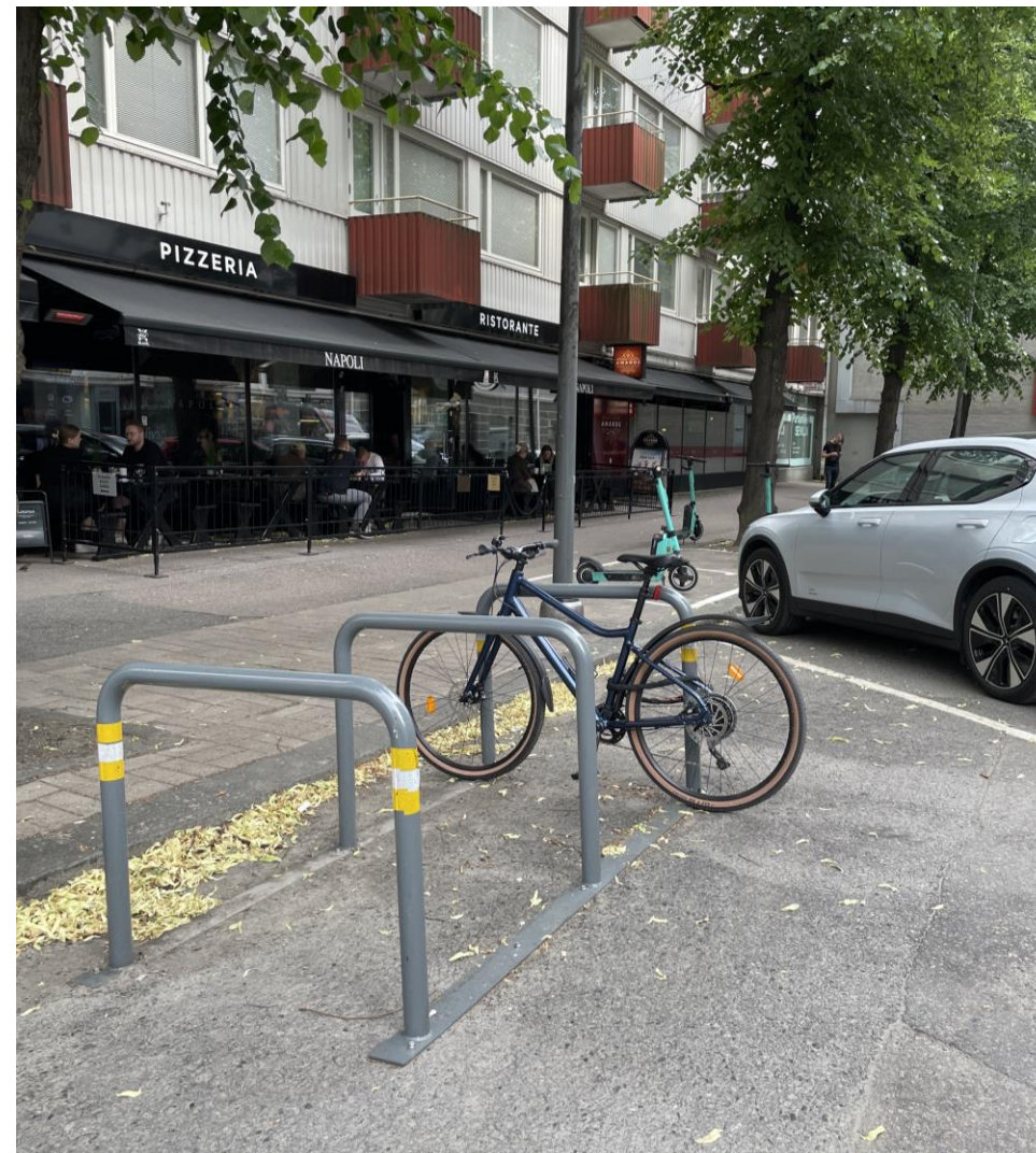
Esimerkki pyöräpysäköinnin sijoittelusta Tampereella. Kolmen kaaren kokonaisuus voidaan asentaa päällysteen pinnalle yhtenä kappaleena.
