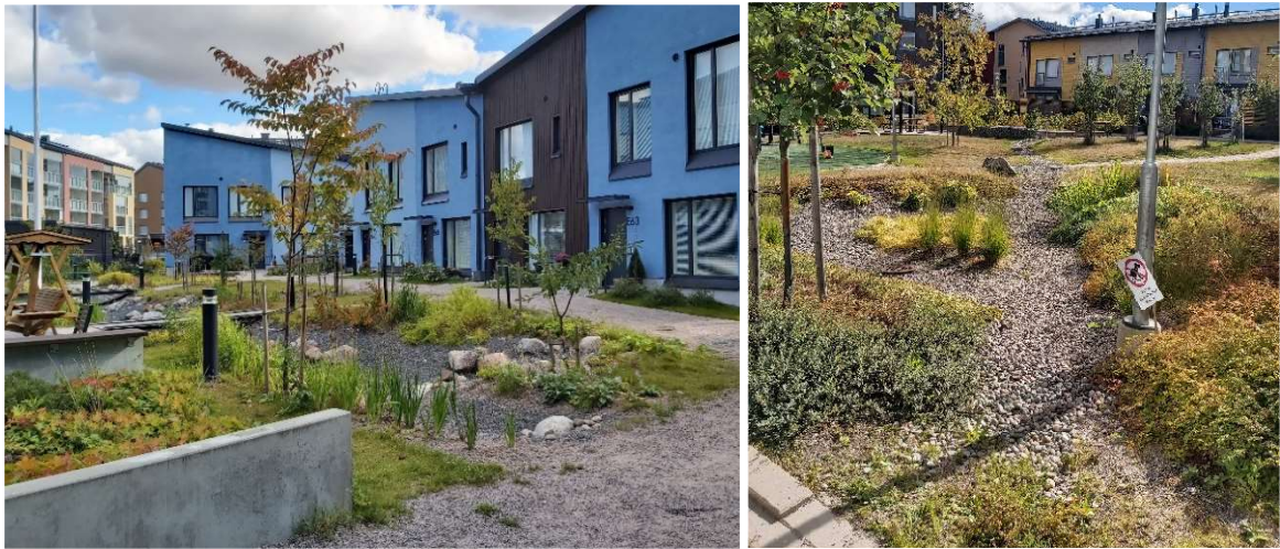
Kuva 3. Kiinteistöjen hulevesirakenteissa mitoituserusteena on usein 1 \text{ m}^3 / 100 \text{ m}^2 läpäisemätöntä pintaa, joka vastaa n. 10 mm sademäärää. Kuvassa on esitetty kiinteistökohtaista hulevesien hallintaa Helsingin Kuninkaantammassa. Kuvat Ramboll/Jalonen.
