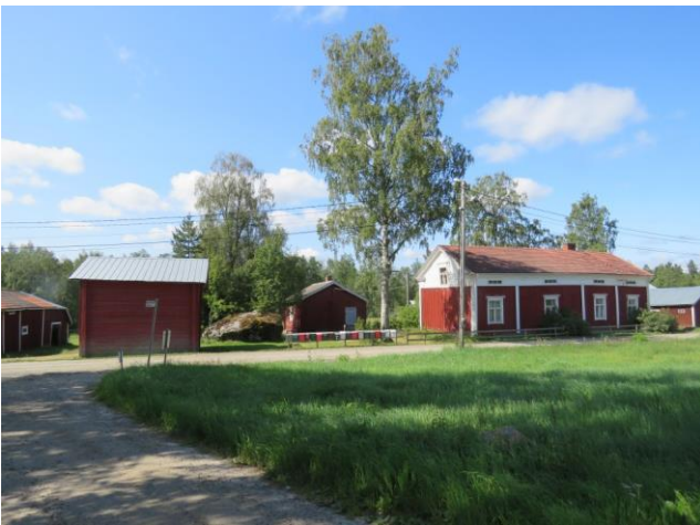
Byggnadsbestånd längs Gamla Pirilövägen, väster om Kyrkoby byaområde.
