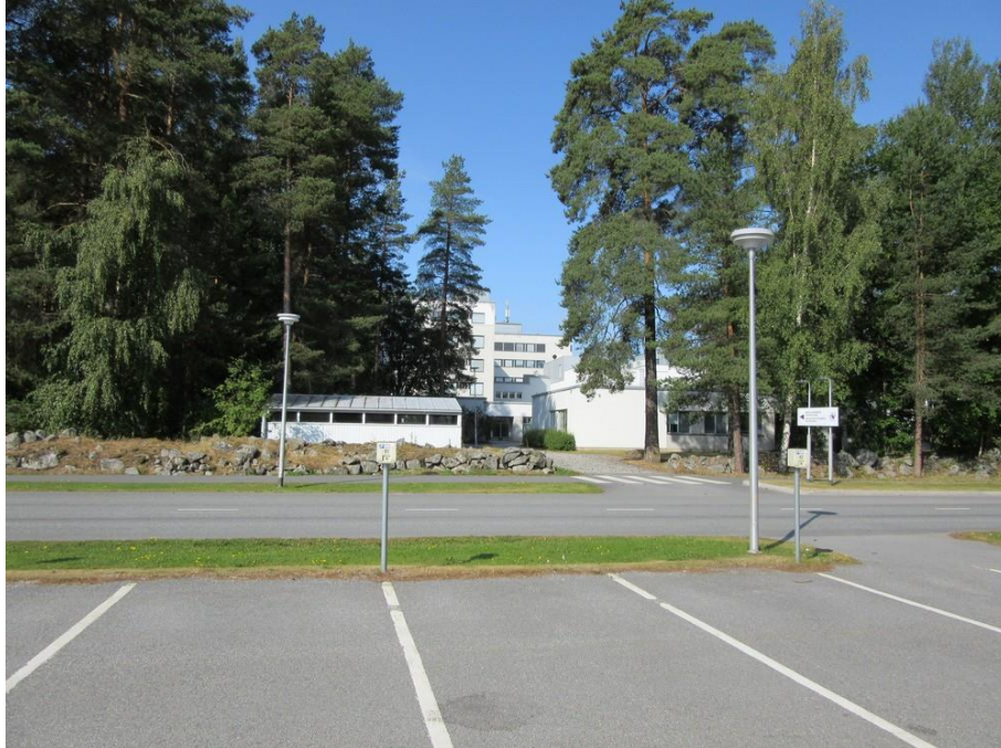
Stenmurar mellan parkeringsområdet och sjukhusbyggnaderna, fotograferat mot väster.
