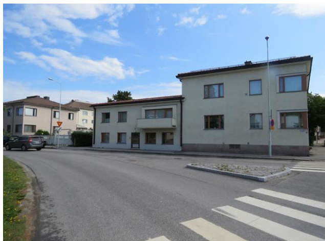
Byggnadernas fasader mot öster på tomt K III 10-32.
