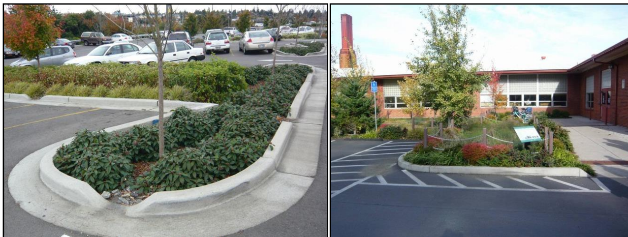
Bild 6. Bilden ovan till vänster: Den underjordiska fördröjningsvolymen är 300 m 3 vid Tykkienkatu i Tammerfors. Bilden ovan till höger: ett exempel på en vattentät tank 6 . Bilden i mitten till vänster: Typbild över biofiltreringsstrukturen 4 . Bild i mitten till höger: ett exempel på hantering av dagvatten i Tusby. Bilderna nedan: dagvattenhantering på parkeringsplatsen och skolgården. 5
