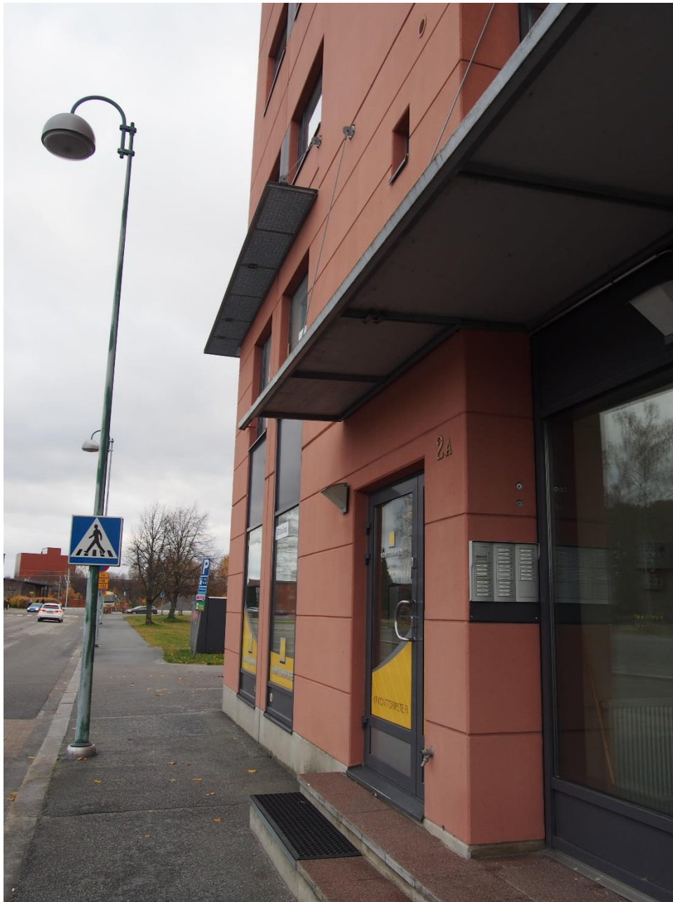
Bild 10. Före detta distributionsstation, Köpmansgatan 2.
