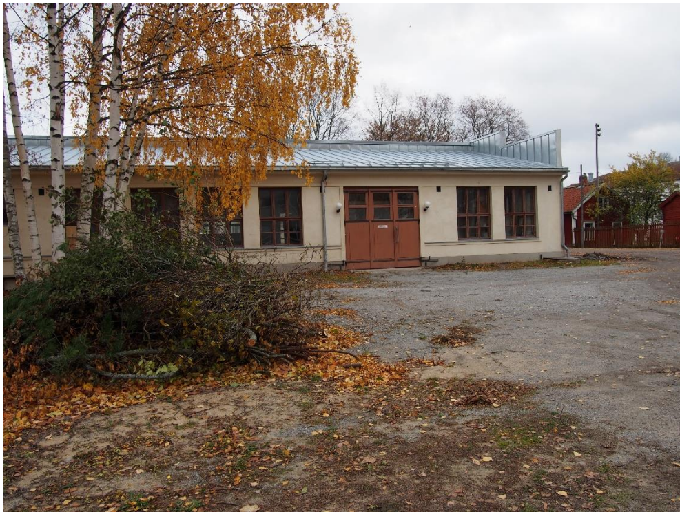
Bild 9. Före detta servicestation, Otto Malmgatan 3.
