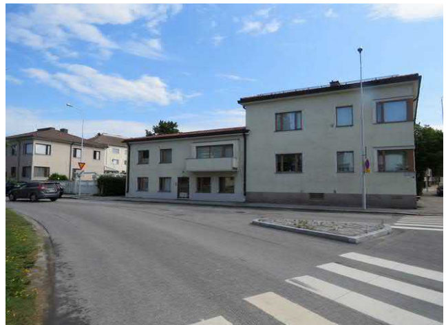
Tontin K III 10-32 rakennusten julkisivu itään.
