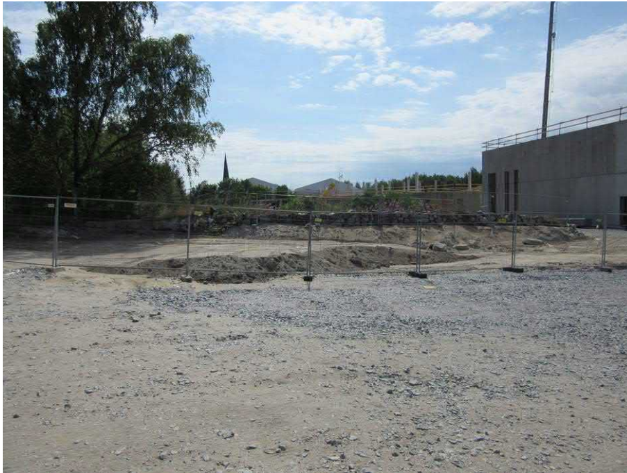
Galgbacken. Aita jäähallin itäpuolella oli rajattu maansiirtotöiden ulkopuolelle, kuva etelään.
