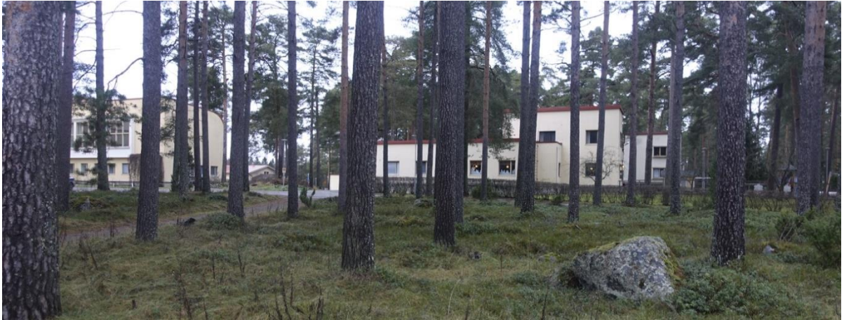
Bild 5. Till vänster sjukhusets byggnadsdel B samt före detta bostadshud för biträdande läkare fotograferat från tallskogen.
