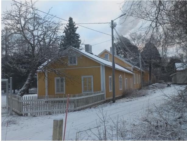
Bild 7. Två bostadsbyggnader som troligtvis uppförts i slutet av 1800-talet eller i början av 1900-talet. Utbyggd i flera etapper.
