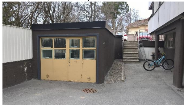
Infarten med ramp ner till f.d. bilhallen. Sisäänajoramppi entiseen autohalliin.
