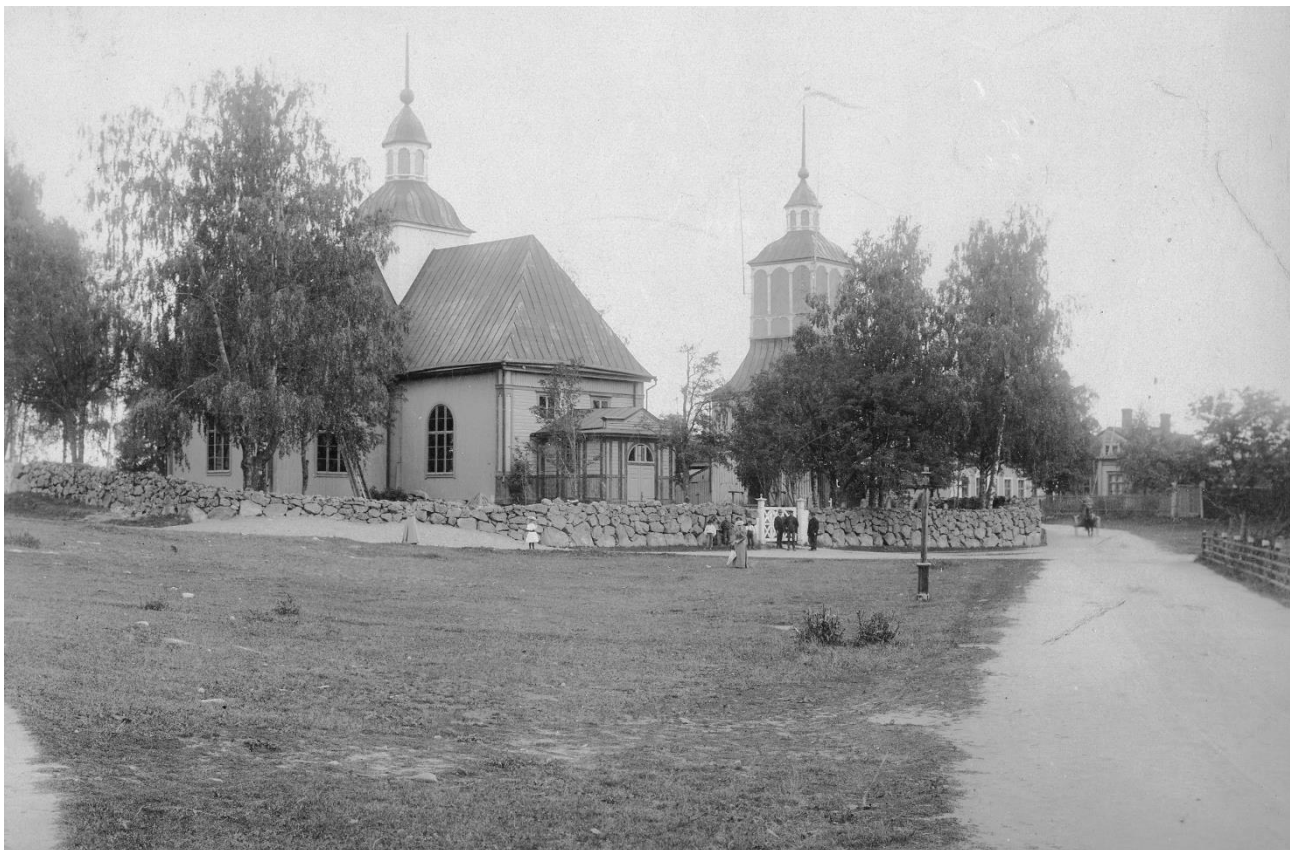
Jakobstads kyrka och klocktorn ca 1890 innan ringmuren byttes ut mot ett gjutjärnsstaket. Pietarsaaren kirkko ja kellotorni noin vuonna 1890, ennen kuin kivimuuri vaihdettiin valurauta-aitaan.
